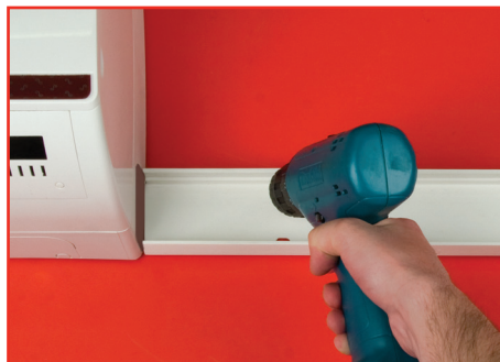
Закрепите основание короба на стене
