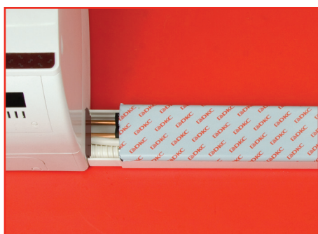
Закройте смонтированную трассу крышкой
